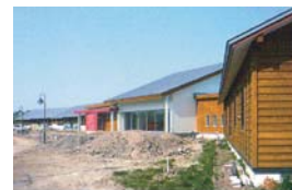
最終工事中の施設状況
